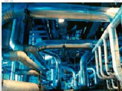
ΕΓΚΑΤΑΣΤΑΣΕΙΣ 3E ΘΕΡΜΗΣ
